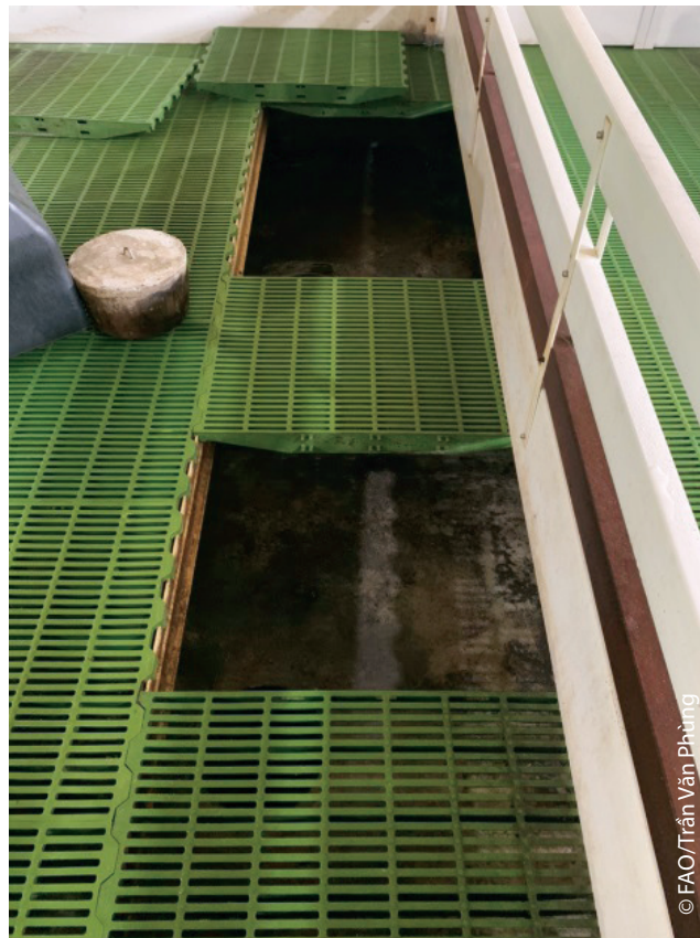
Hình 8. Chất thải được lưu trữ trong hầm bên dưới sàn chuồng
